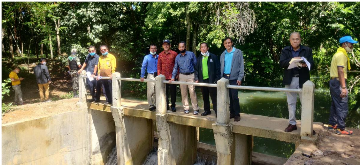
(โครงการก่อสร้างฝายชะลอน้ำเพื่อรักษาความชุ่มชื้นของป่าต้นน้ำ)
