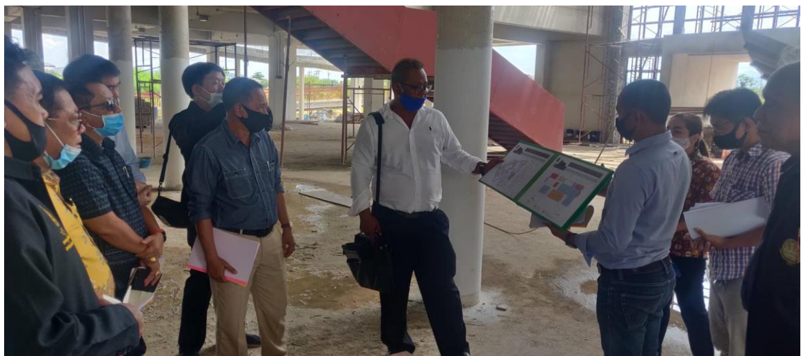
(โครงการพิพิธภัณฑ์ผังเมืองยะลา กิจกรรมก่อสร้างอาคารพิพิธภัณฑ์ผังเมืองยะลา โครงสร้างคอนกรีตเสริมเหล็ก)
